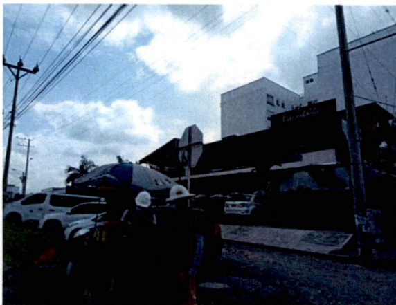
SEGUIMIENTO ACTIVIDADES DE EXCAVACIÓN
