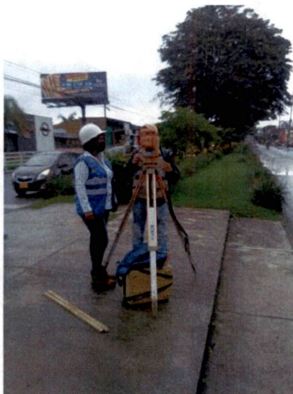
CHEQUEO TOPOGRAFIA CON REPLANTEO
