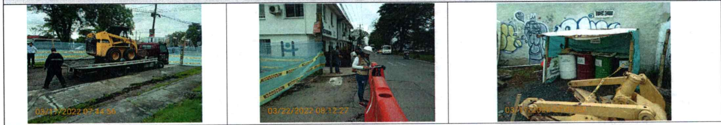
SEGUIMIENTO TRANSPORTE DE MAQUINARIA ACOMPAÑAMIENTO ACTIVIDAD MONITOREO RUIDO NI ETAPA CONSTRUCCION VERIFICACION PUNTO ECOLÓGICO DISPUESTO EN FRENTE DE OBRA
