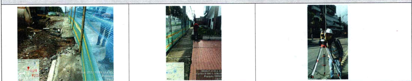
Demolicion, en (Carrera 9 entre Calles 11N y Calle 14N). abs K0+020 a K0+ 030. Desmonte de fachadas (Carrera 9 entre Calles 13N y Calle 14N). abs K0+050 a K0+ 100. Topografía, en (Carrera 9 entre Calles 19N y Calle 23N). abs K0+600 a K1+ 200
