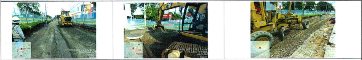
CEREO DE SUBBASE EN LA CARRERA 9 ENTRE CALLE 14N A 15N CAJEO DE SUBRASANTE EN CARRERA 9 CON CALLE 11N EXTENSION DE SUBBASE EN LA CARRERA 9
