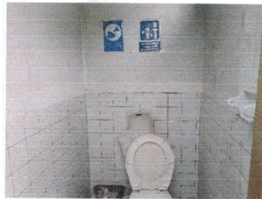
Adecuación baño para trabajadores
