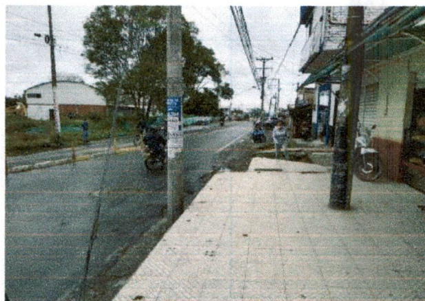
Estado inicial del espacio público a intervenir,
