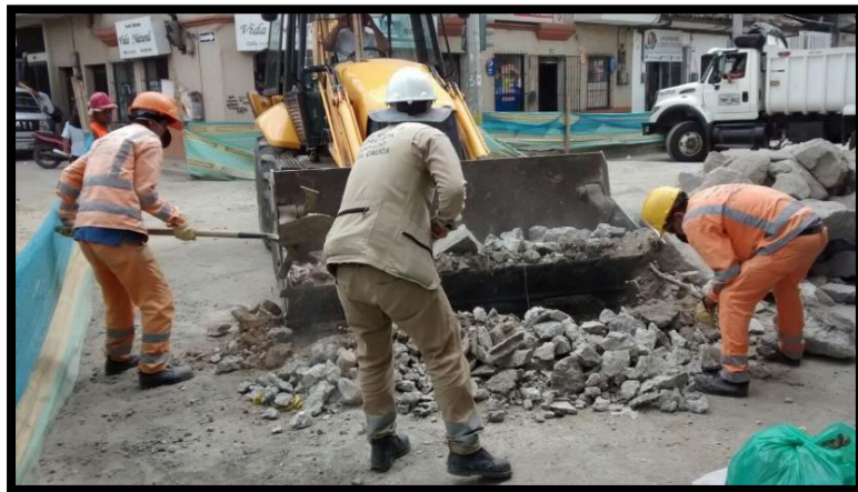
Fotografía 28. Manejo De Escombros
