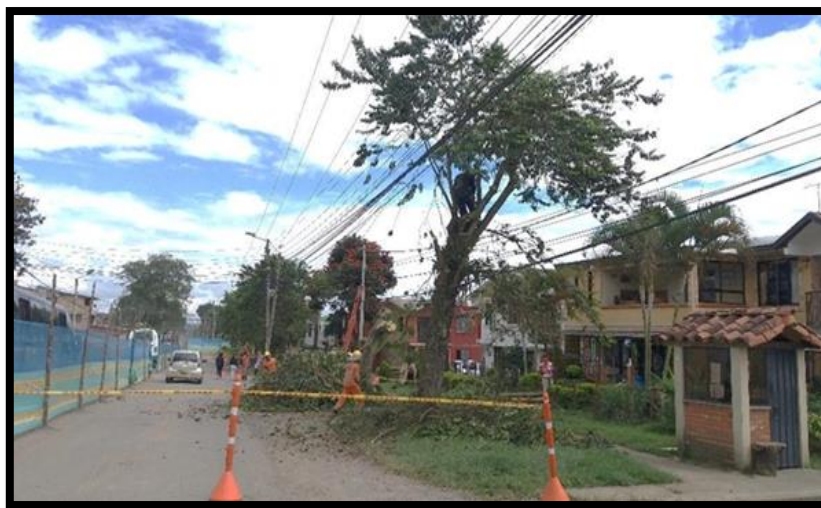
Fotografía 14. Señalización de la zona de tala de árboles
