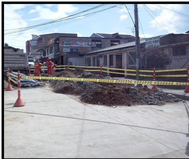
Fotografía 29. Almacenamiento Temporal De Escombros
