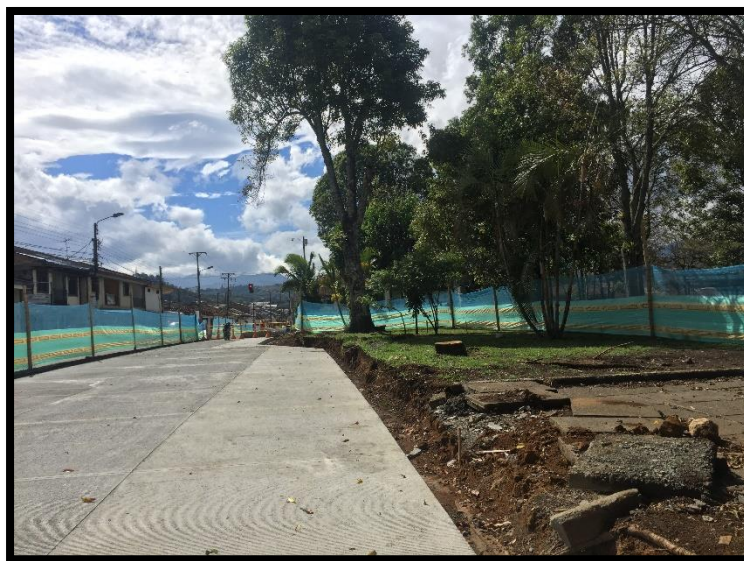
Fotografía 39. Cierre De La Obra
