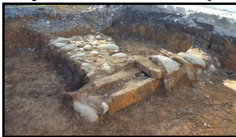
Fotografía 40. Canal De Alcantarillado Siglo XX
