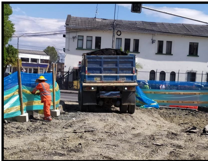
Fotografía 30. Volquetas Con Material Cubierto
