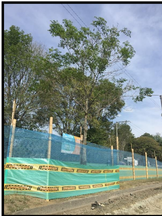
Fotografía 25. Protección de individuos con mallas perimetrales, altura 1m
