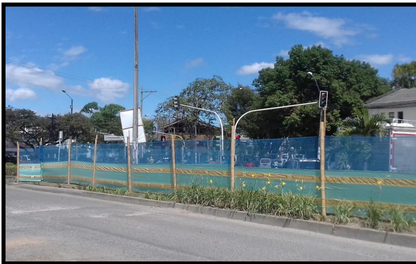
Fotografía 27. Aislamiento Con Poli sombra
