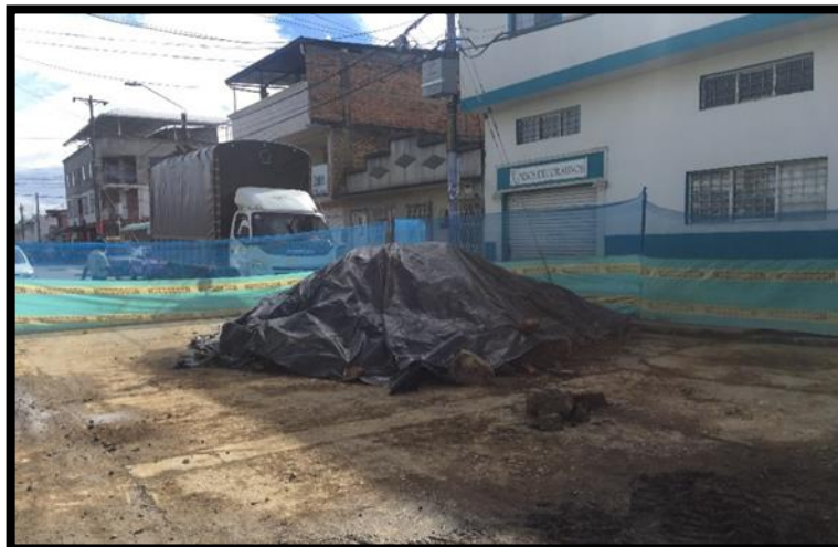
Fotografía 32. Sitio De Almacenamiento De Materiales
