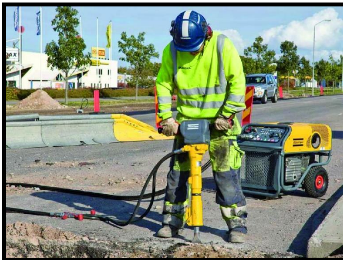
Fotografía 38. Empleo Del Martillo De Demolición
