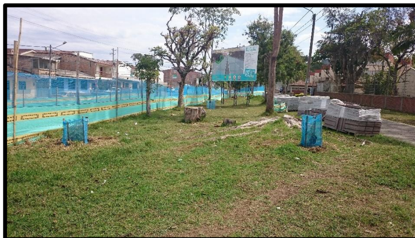
Fotografía 26. Cierre de Obra
