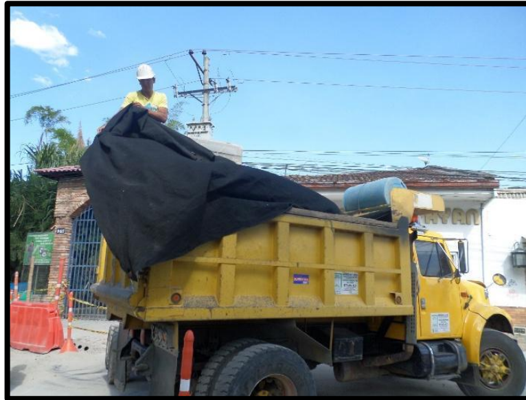
Fotografía 15. Volquetas con material cubierto
