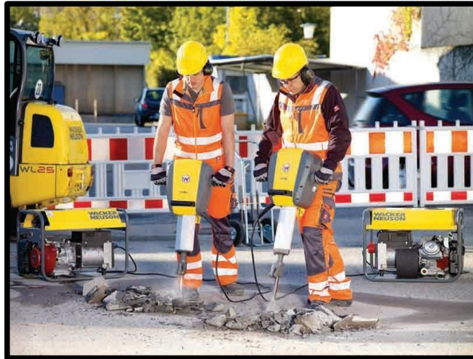
Fotografía 25. Empleo de martillo de demolición.
