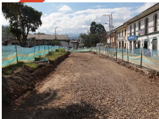
Tramo 1 Nuevo. Calle 7 N. Sector - Barrio Bolívar
